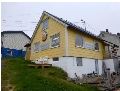
Die Häuser werden mit übers Dach gespannten Drahtseilen im Boden oder an den Fundamenten verankert (Sturmgefahr).
